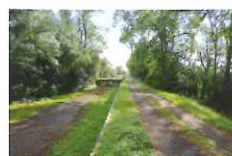
Étude sur les voies en remblai
